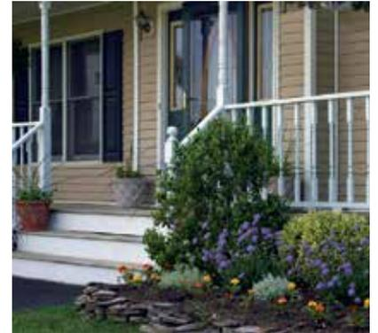
Abb. 7 Überdachtes Hauseingangspodest. Einfacher Übergang zum Haus. Holzpodeste halten den Sockel an den Hauseingängen trocken!
