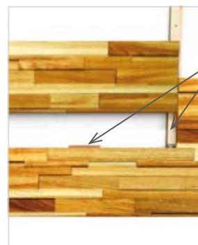
Die Holzfeder stecken Sie so wie die Verbindungskralle in die Nut zwischen den Paneelen, für bessere Stabilität. Besonders bei Wänden, die nach außen gerichtet sind, empfehlen wir für eine Hinterlüftung zu sorgen.
